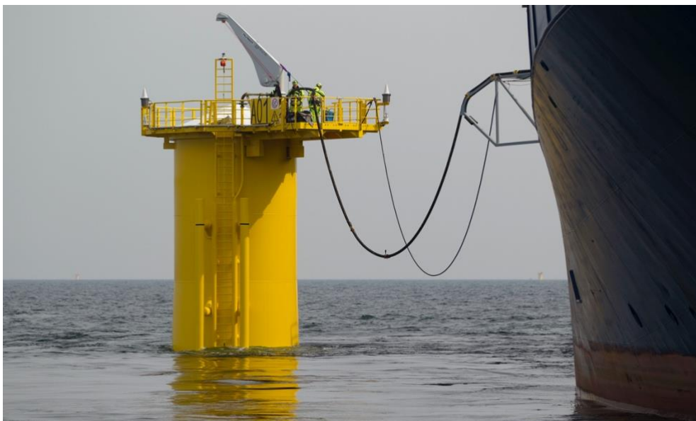
Bilde 3: Montering av fundament til Grenaa havvindpark i Danmark (copyright Europakommisjonen)
